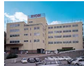
▲リョービ株式会社 印刷機器工場
