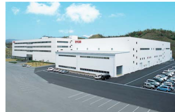
▲グラフィックシステム第2工場(手前)
