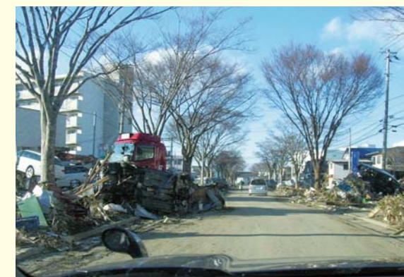
仙台営業所周辺の津波被害
