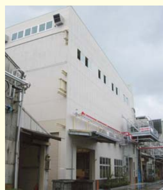
耐震性が強化された新鋳造工場
