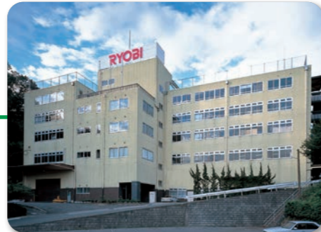
リョービ株式会社 印刷機器工場 〒726-0023 広島県府中市栗柄町444-1
