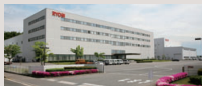
グラフィックシステム第2工場（右奥）
