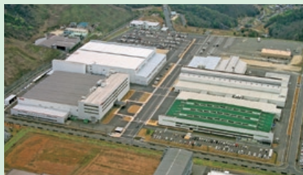
広島東工場の全景
