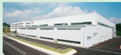
増築工事が完了した第2工場(手前)
